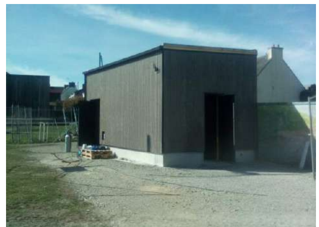
Une chaufferie développée par la SCIC Koad COB.
